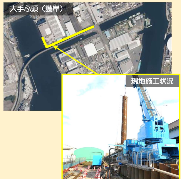
防潮壁の防災機能強化
