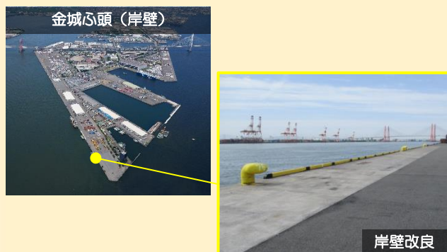
岸壁の老朽化対策
